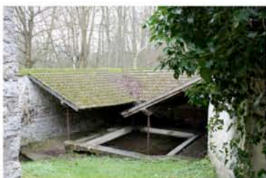
30-Lavoir rue St Martin
