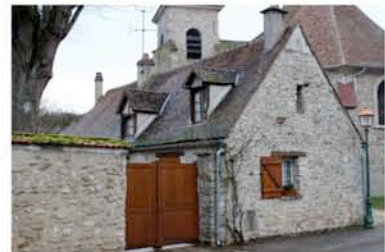
7-4 rue de l'Eglise (ancien presbytère)
