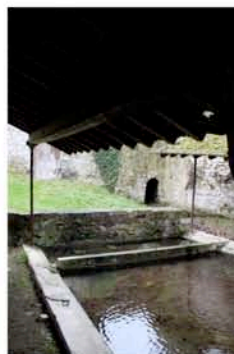
30bis-Lavoir rue St Martin
