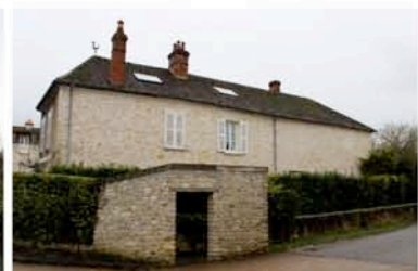
10-Lavoir rue du Moulin
