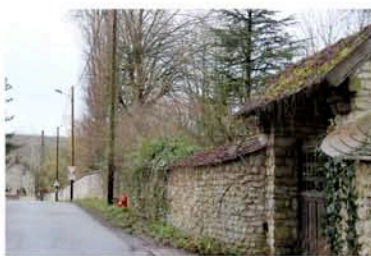
36-Mur rue St Martin à rue du Calvaire
