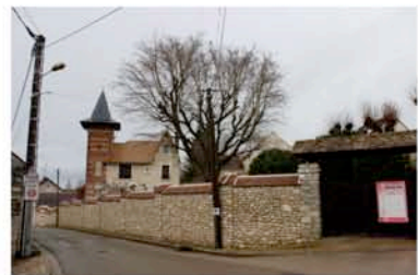
29bis Mur maison de la Tour rue St Martin
