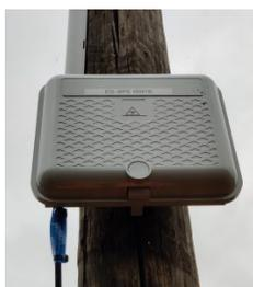
Ce boîtier, appelé PBO (point de branchement optique) est l'équipement permettant de raccorder le câble public avec le câble privé directement raccordé au DTlo près de votre box internet. Le point de branchement optique peut se trouver en pied d'immeuble ou à l'extérieur de l'habitat. Le DTlo dispositif de terminaison intérieur optique est la prise permettant le branchement de votre box internet à la mise en service de votre abonnement très haut débit.
